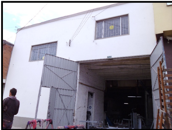
Foto 1. Vista general del predio
