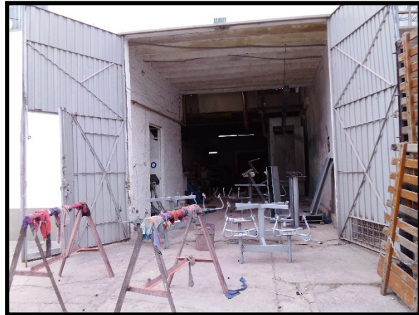
Foto 2. Trabajo en vía pública
